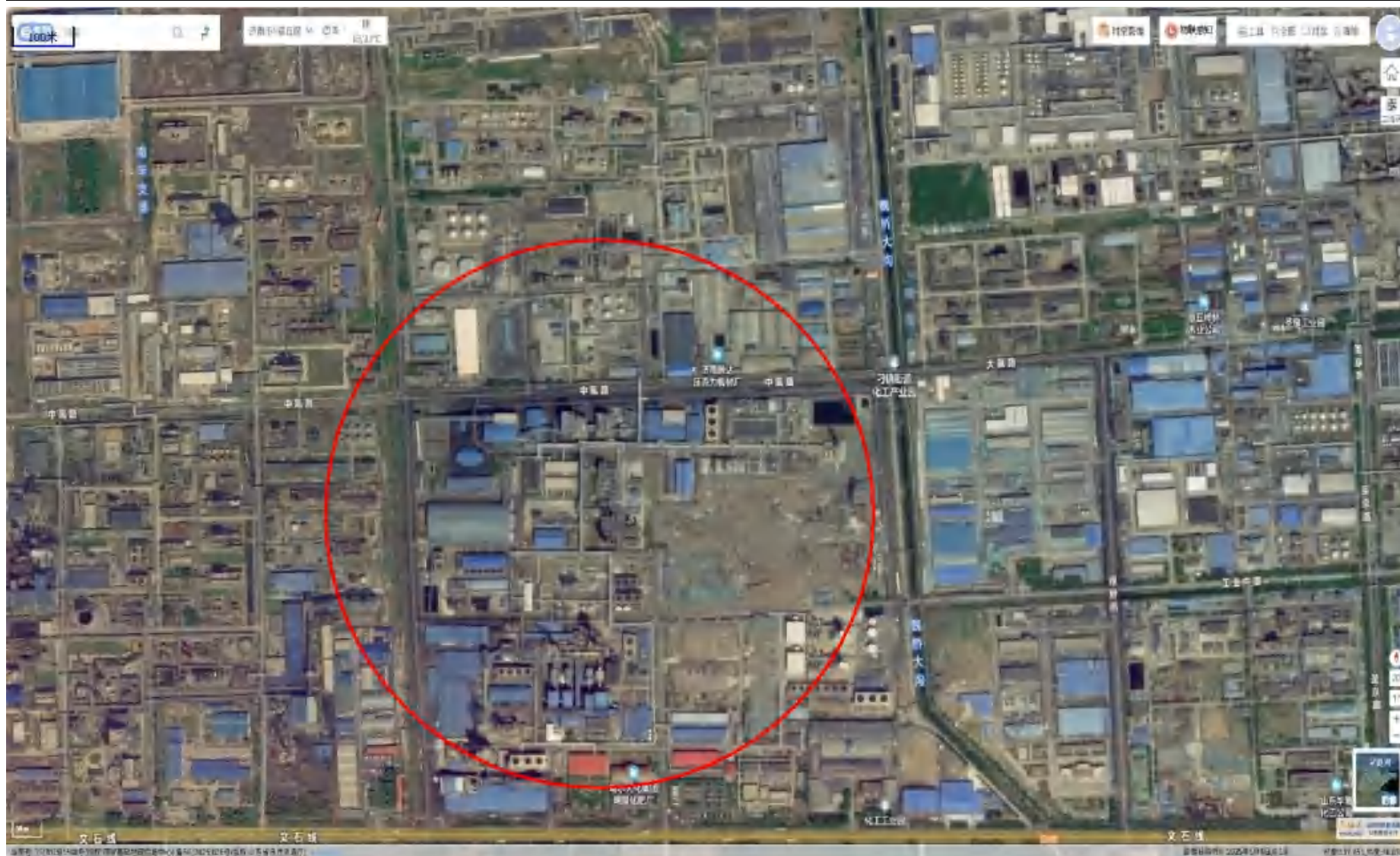
图 C-3-3 低甲：变换气洗涤塔塔器完全破裂（闪火：2.7m/s,D 类）事故后果图
