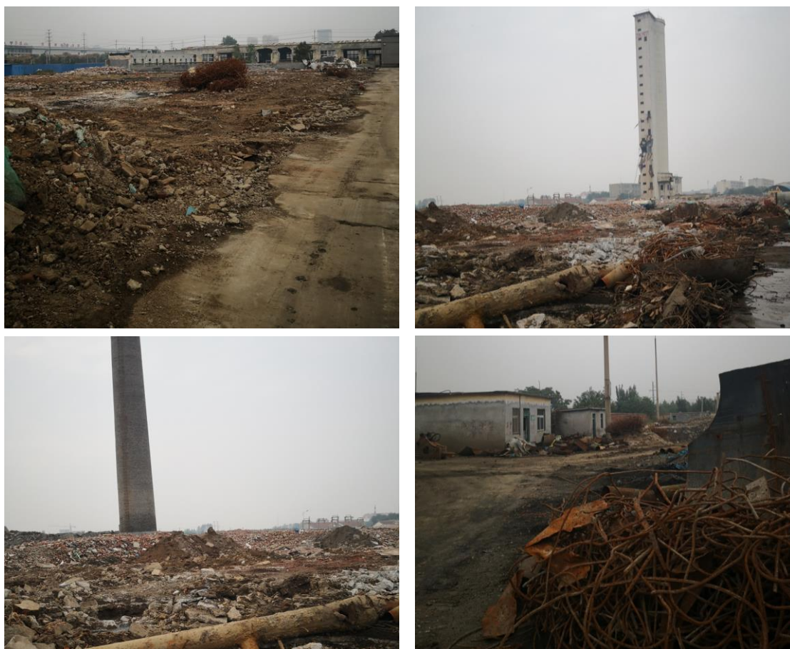
图 3.3-2 基本拆除后现场情况
