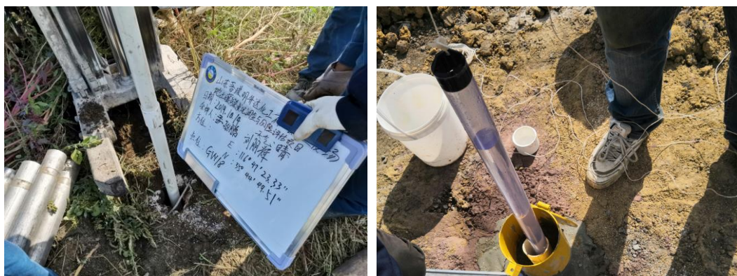
图 4.1-14 地下水建井和洗井
