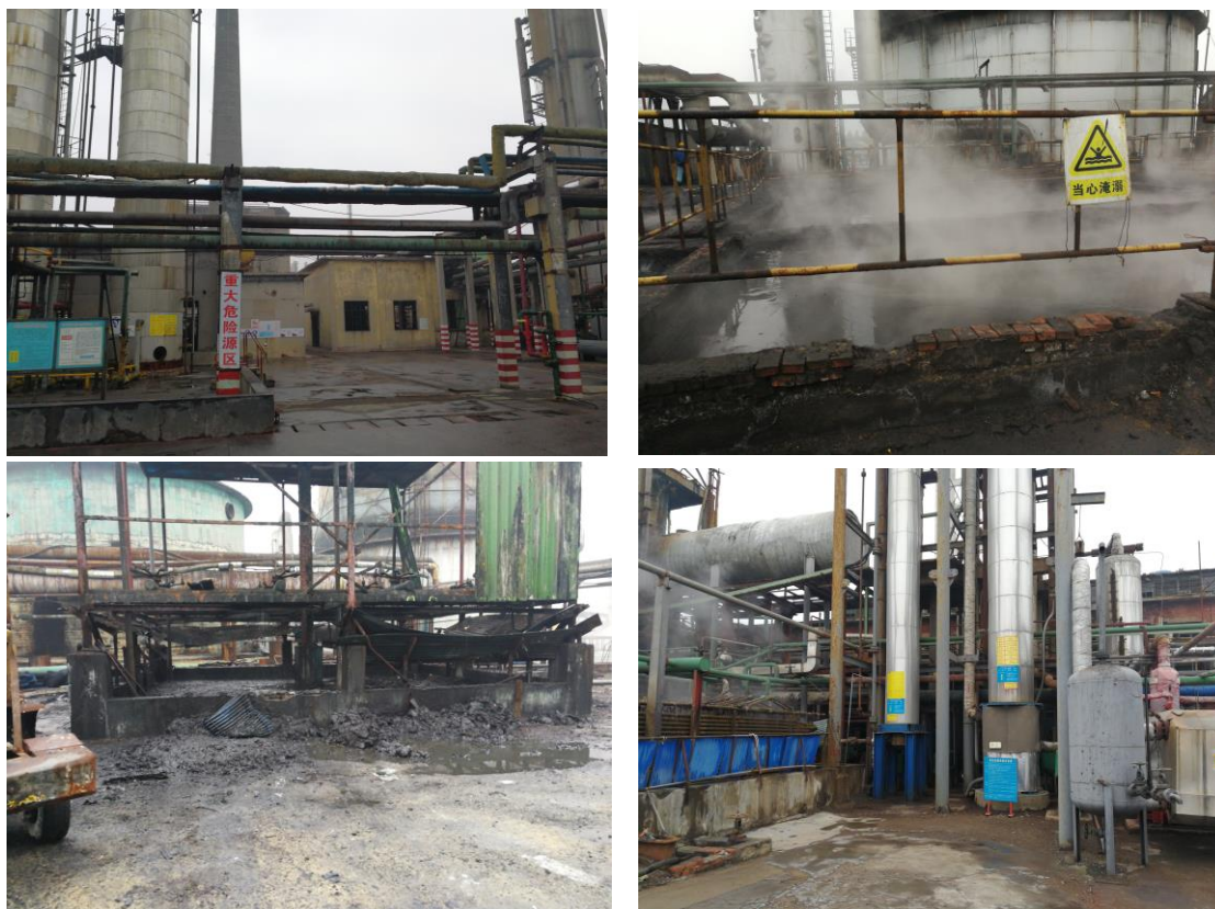
图 3.3-1 未拆除前现场情况
