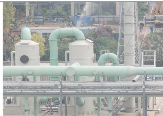
污水站废气排气筒
